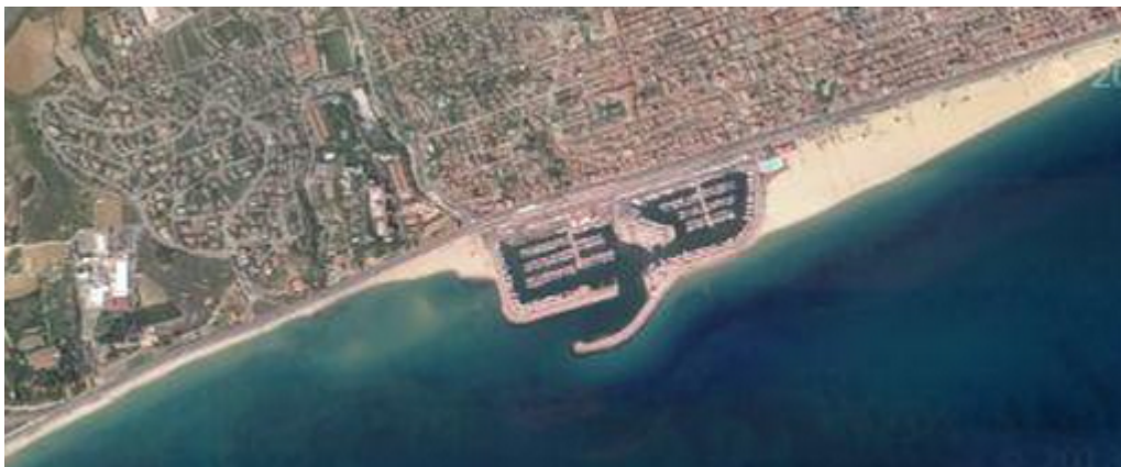
Figura 6: Erosió en la part sud-oest del port de Masnou.[Font: Google Earth]
