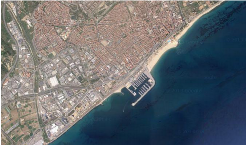
Figura 5: Exemple de l'acreció de la costa al port de Mataró.[Font: Google Earth]
