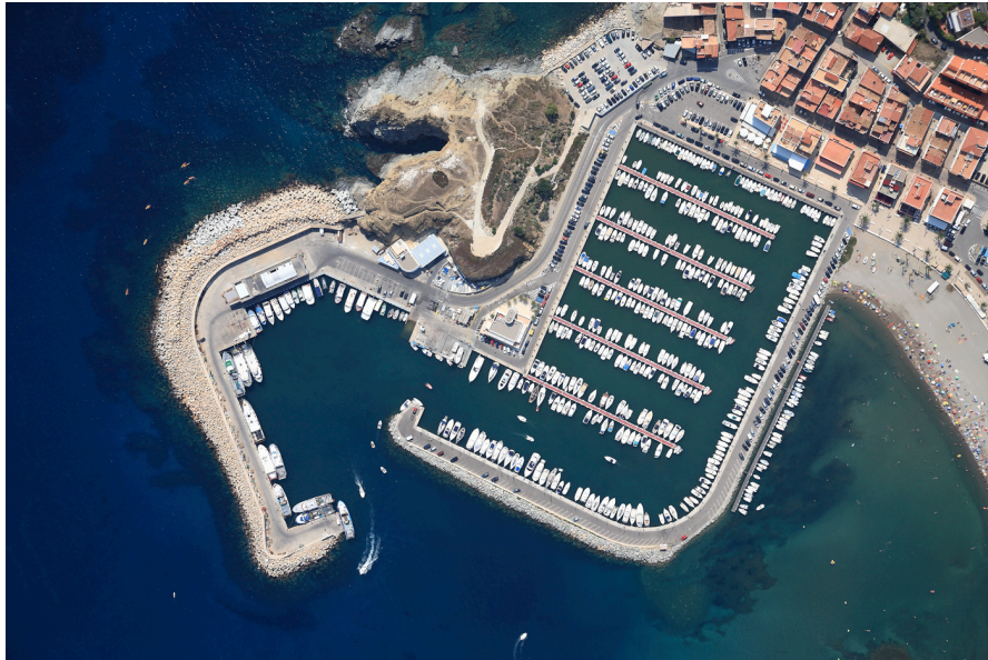
Figura 4: Port de Llançà, situat en un tram de costa molt abrupte.[Font: Ports de la Generalitat de Catalunya]
